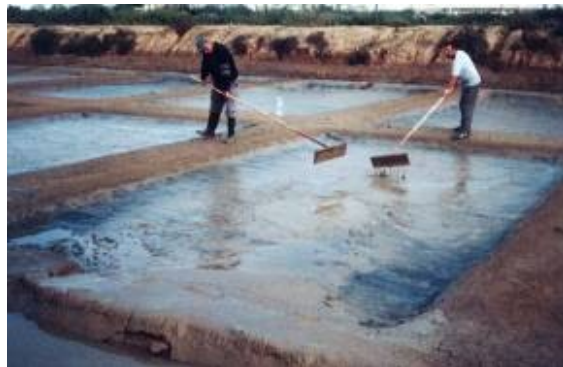
Figura 7 - Remoção dos lodos
