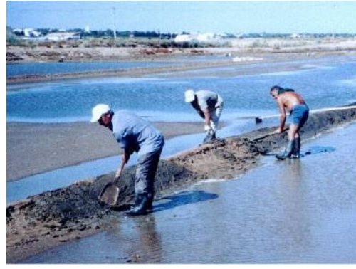
Figura 5 - Reconstrução das Motas dos Viveiros de Águas Quentes
