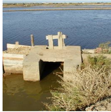
Figura 10 - Comporta de Segurança para Sustentação de Águas
