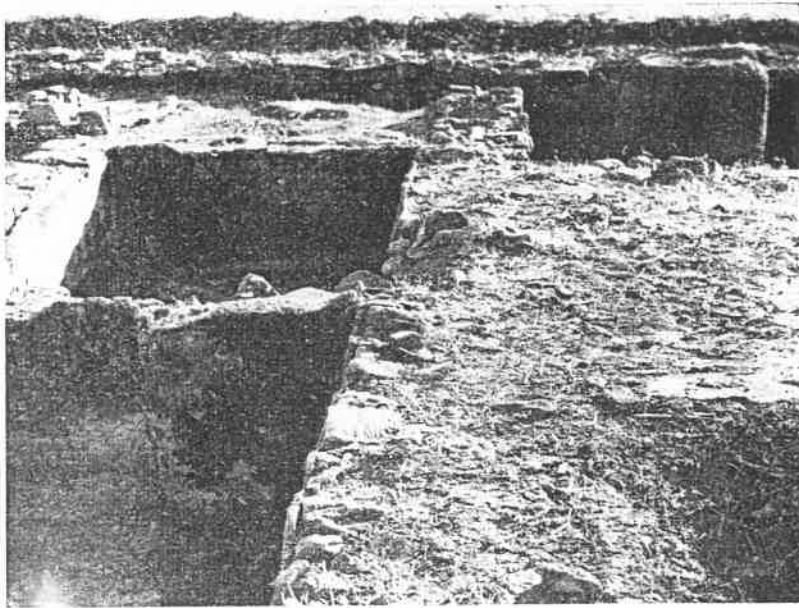
Lagar romano de Palma vendo-se: à direita, o «peso» e o bancada de espremedura com a depressão onde está instalada a vasilha destinada a receber o primeiro produto da prensagem; à esquerda, dois tanques de decantação.
